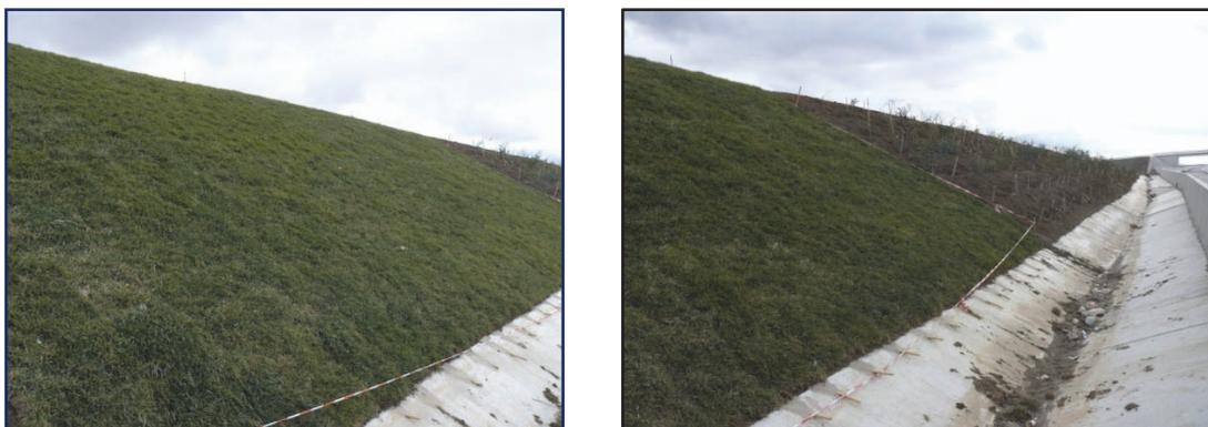
Figure 11. Les talus marneux après traitement par les deux géosynthétiques.
