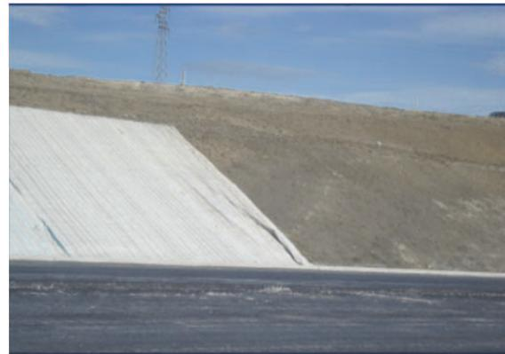
Figure 6. Mise en œuvre du géocomposite de drainage.
